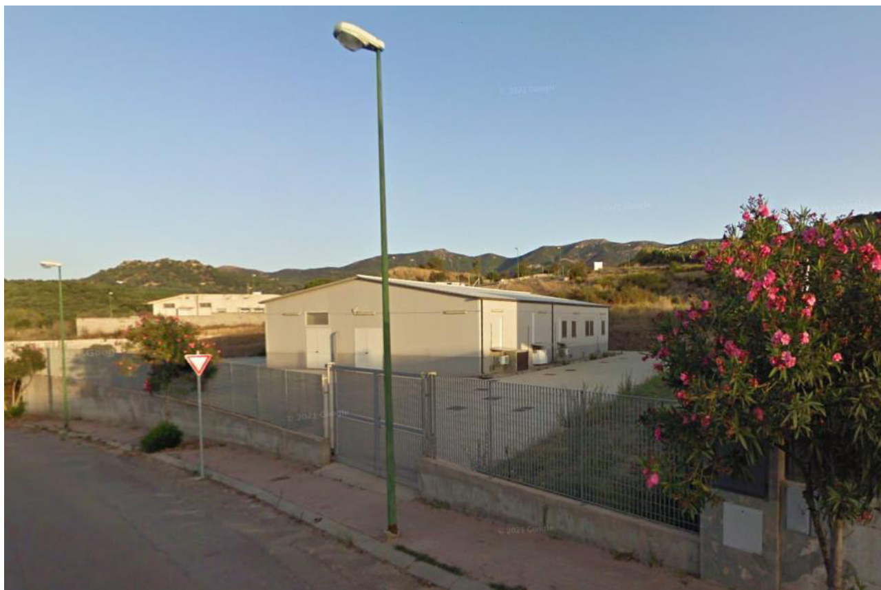
Vista Ingresso Area P.I.P.
