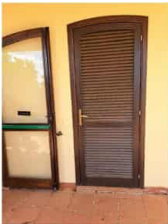
7 Vista infissi esterni
