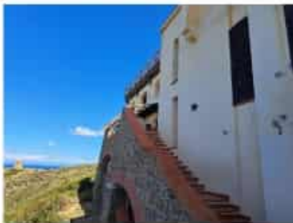
10 Vista facciata lato mare
