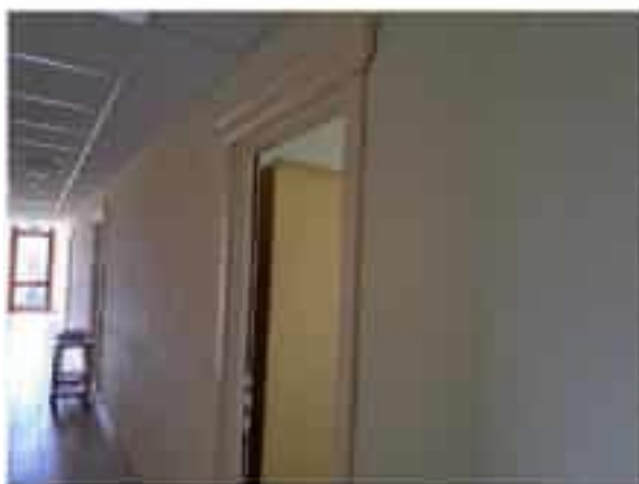
53 Dettaglio stipiti porte di accesso alle camere
