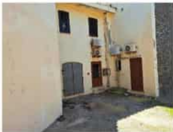
78 Ingresso vani tecnici
