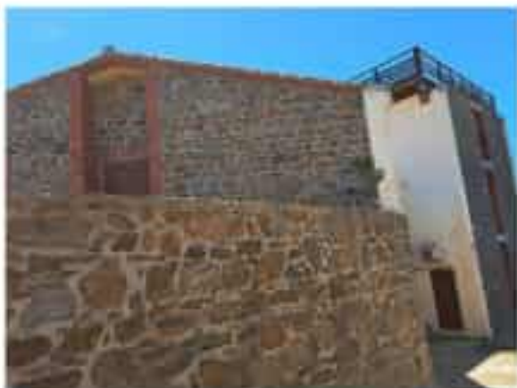
79 Facciata lato nord-ovest
