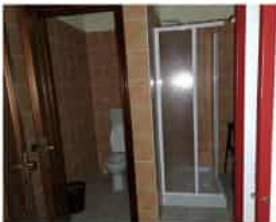
21 Vista servizio igienico e doccia spogliatoi
