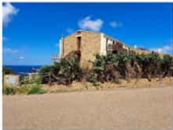
1 Vista esterna della struttura da via della Torre
