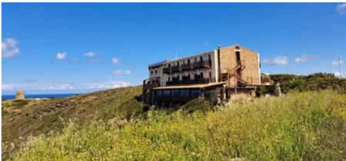
Figura 5 Vista della struttura con sullo sfondo la Torre di Flumentorgiu.
