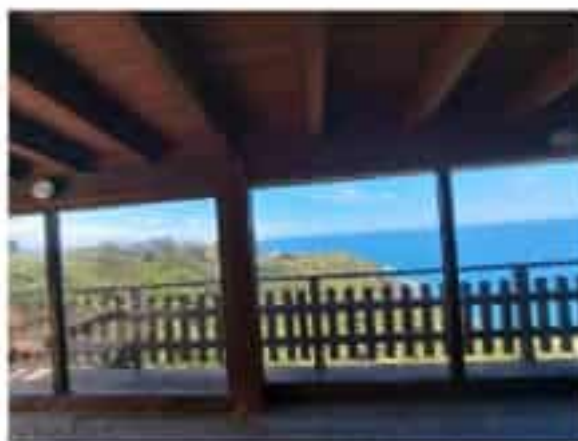
14 Orditura della copertura della veranda
