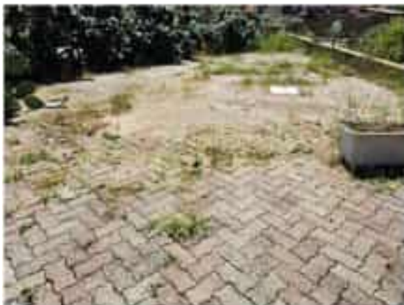
65 Vista pavimentazione esterna cortile
