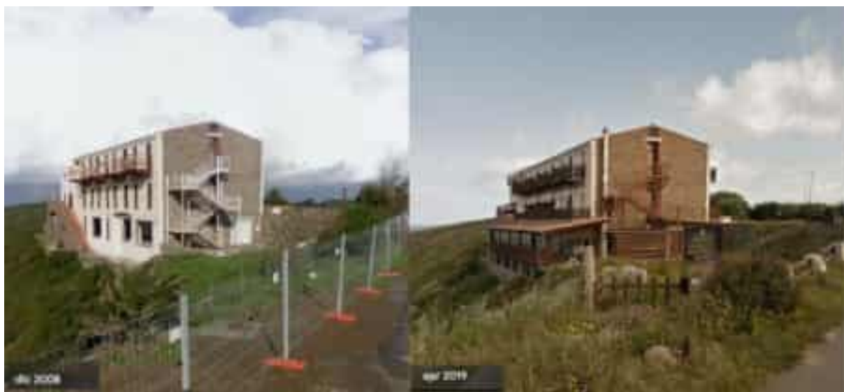
Figura 7 Confronto tra Ex Ostello all'inizio dei lavori di riqualificazione e hotel a intervento ultimato.
