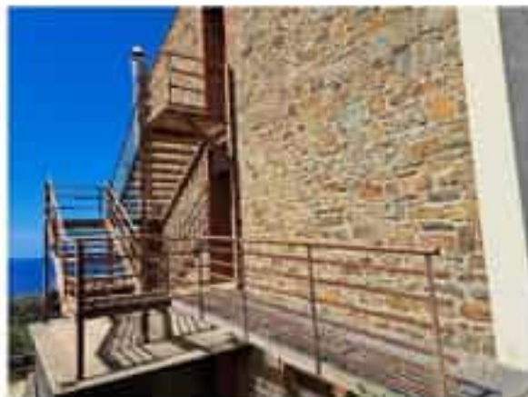
66 Vista scala esterna di sicurezza
